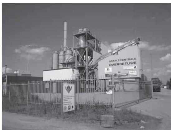
Asfaltcentrale OVERBETUWE in Huissen
