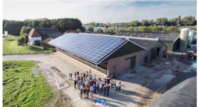
In 6825 liggen al veel zonnepanelen, zie Zuivelboerderij IJsseloord
